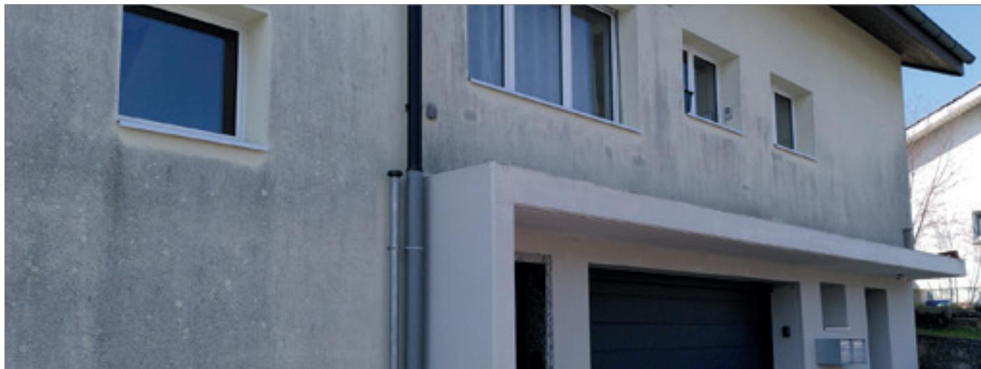
Abb. 1 - Starke Veralgung und Verpilzung an einer Wetterseite in Süddeutschland, u.a. mit Trentepohlia-Algen. Durch streifenförmige Auswaschungen kommt es zum »Tiger-Effekt«. Man beachte die sauberen Bereiche direkt unter dem Dachvorsprung – konstruktiver Fassadenschutz!
