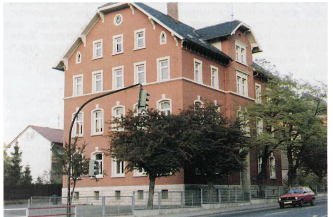
Das Schulgebäude nach der Sanierung 1976 mit BEECK-Silikatfarben.
