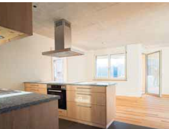
Die Wohnungsdecken im Langhaus sind aus lasiertem Beton, die Holzwände doppelt beplankt und mit der Bürste geschlämmt. Böden und Küchenelemente bestehen aus Schweizer Holz.
